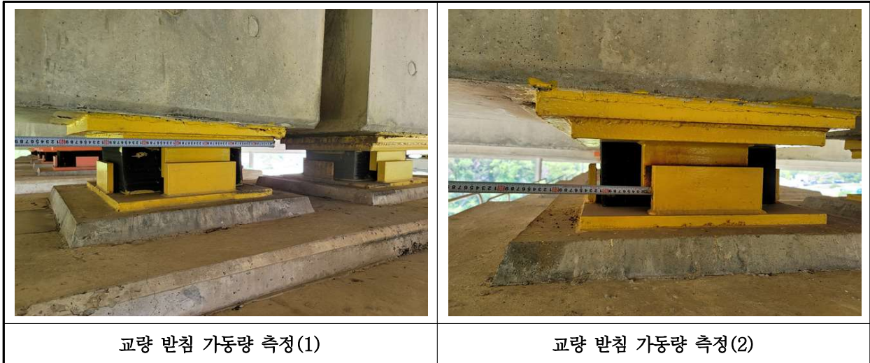
【사진 24.3.16】 교량받침 이동량 측정
