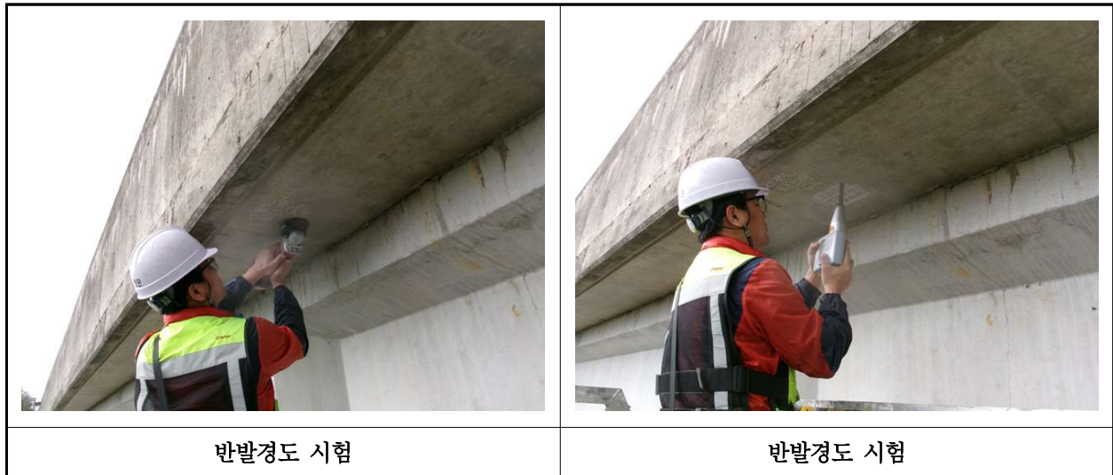
【사진 24.4.2】 반발경도시험 현장사진
