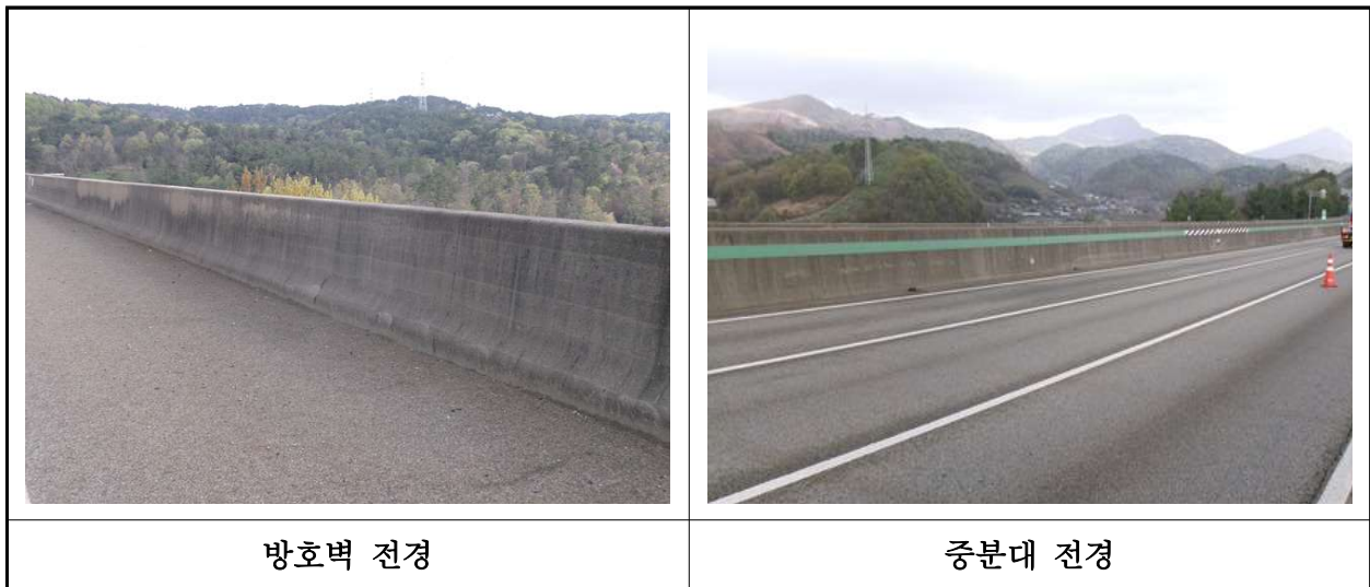
【사진 24.3.24】 방호벽 및 중분대 전경
