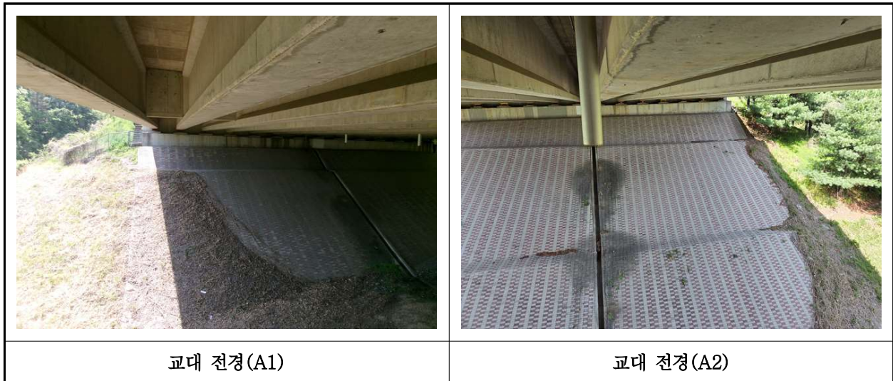
【사진 24.3.8】 교대 전경
