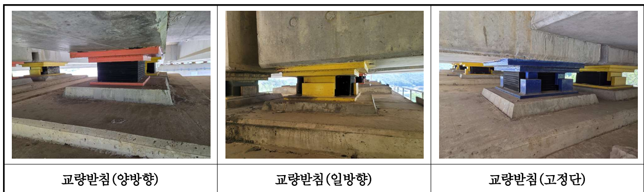
【사진 24.3.13】 교량받침 전경
