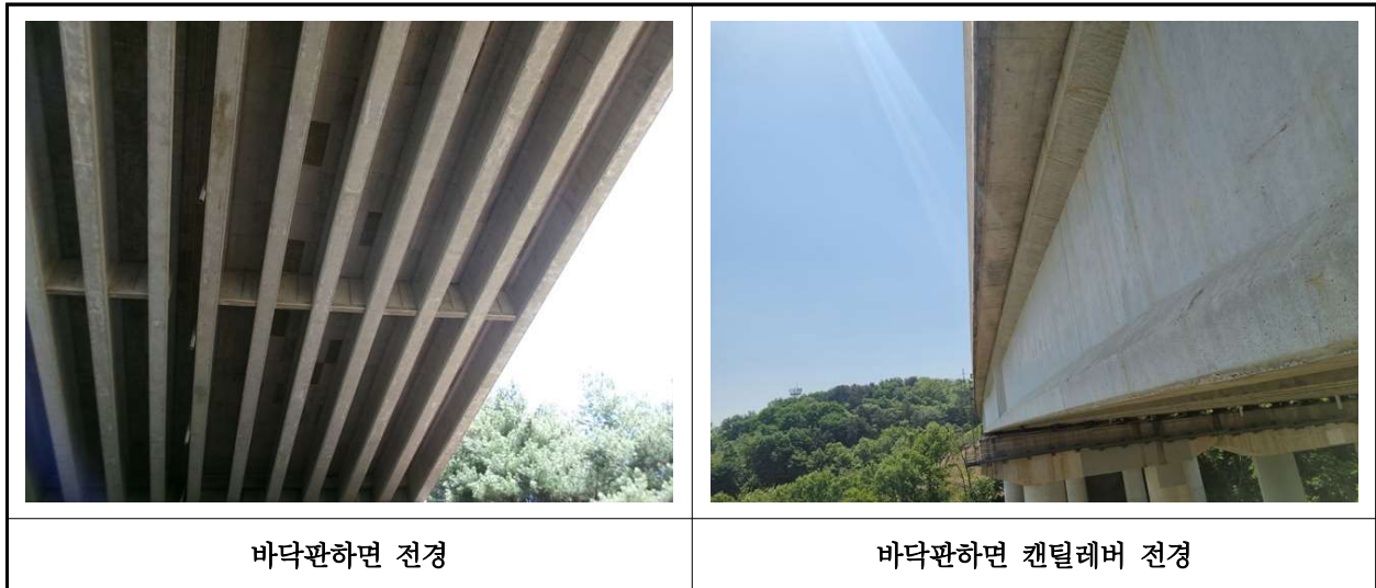
【사진 24.3.2】 바닥판하면 전경
