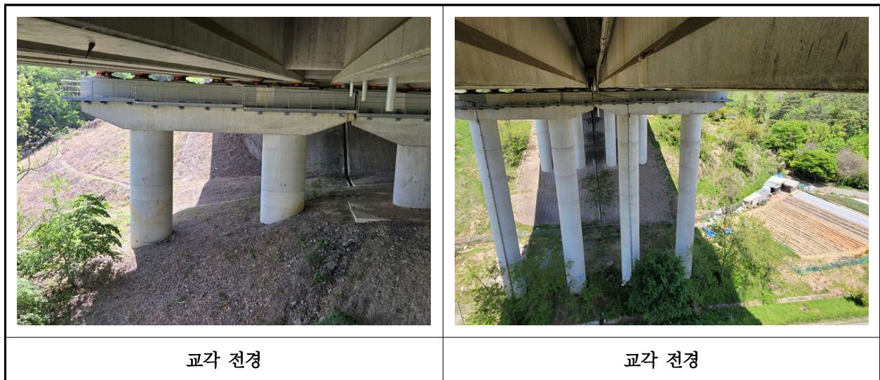
【사진 24.3.10】 교각 전경
