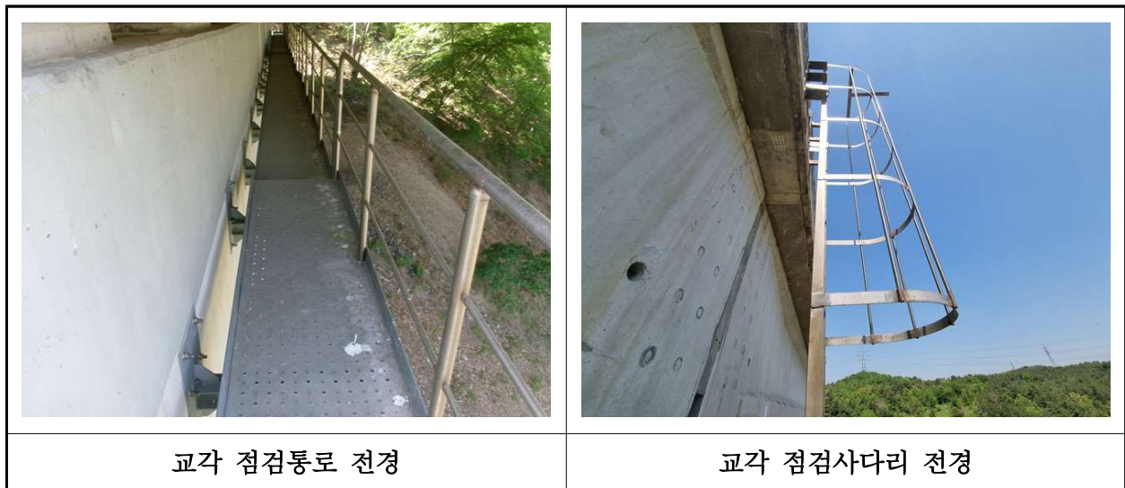
【사진 24.3.26】 교량 점검시설 전경
