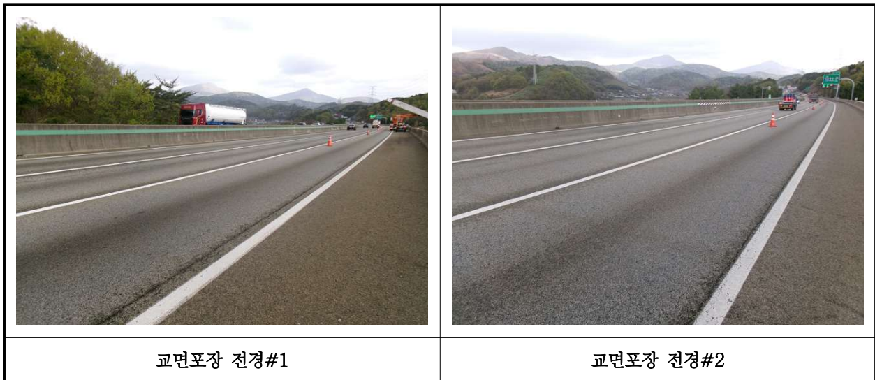
【사진 24.3.20】 교면포장 전경
