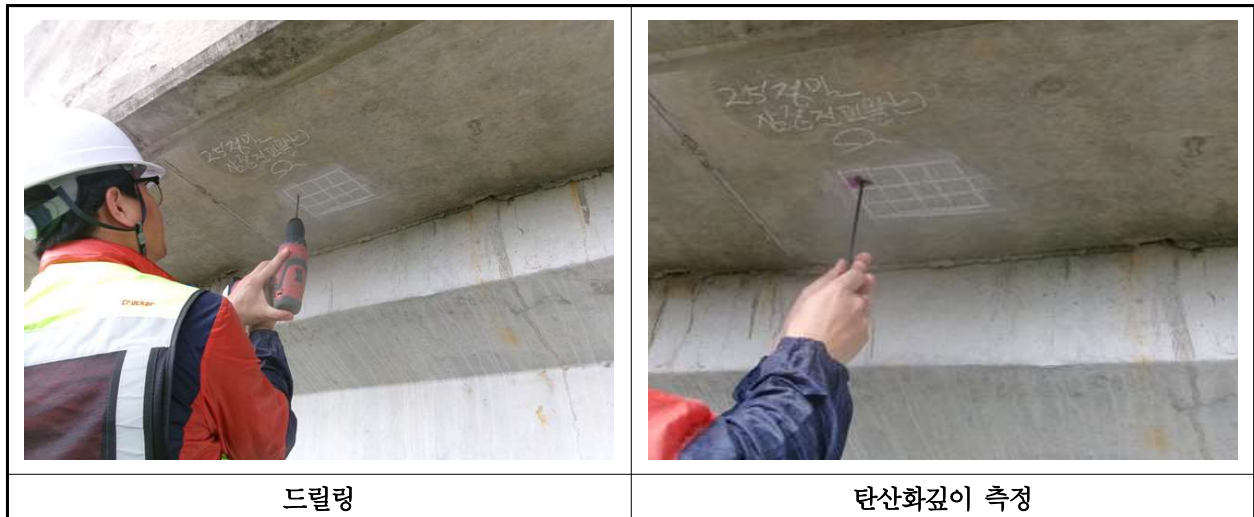
【사진 24.4.3】 탄산화 깊이 측정 현장사진
