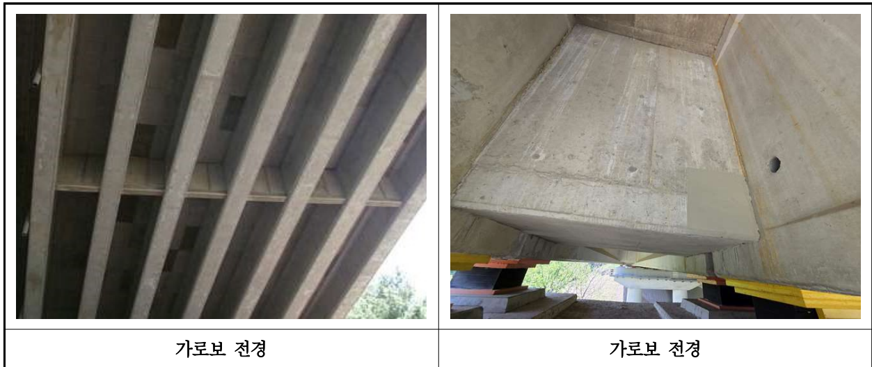
【사진 24.3.6】 가로보 전경
